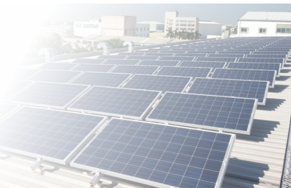
2015 年建置福興廠頂樓建置太陽能板
