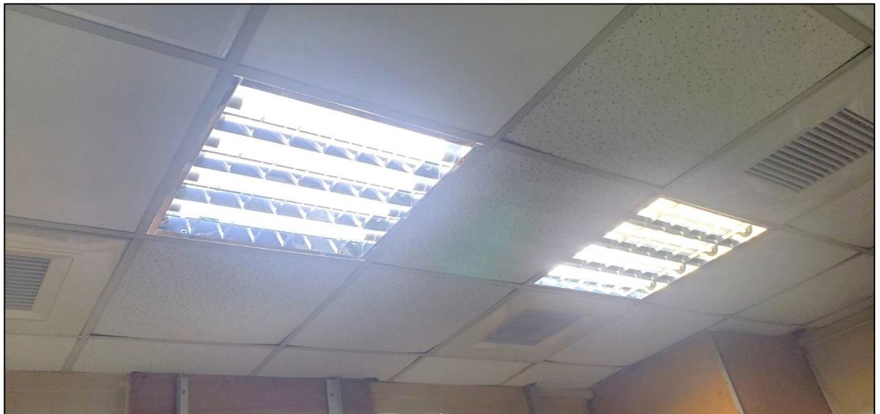
▲ LED燈更換作業
