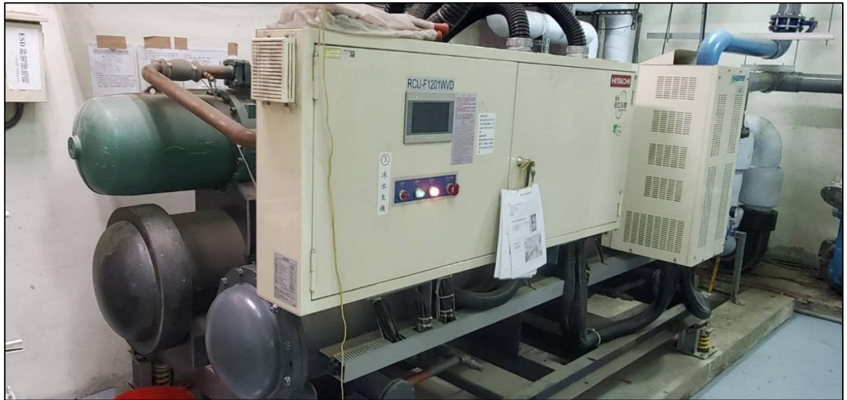
▲ 彰化福興廠120RT冰機汰換作業
